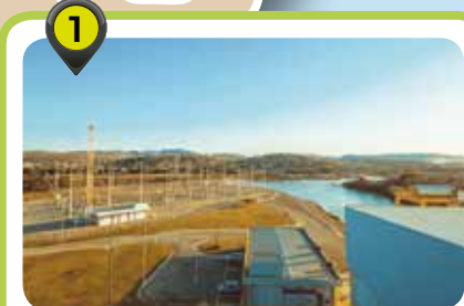
UHE ELIEZER BATISTA Participação acionária: 100% Potência instalada: 330 MW Garantia física: 181,90 MW médio
