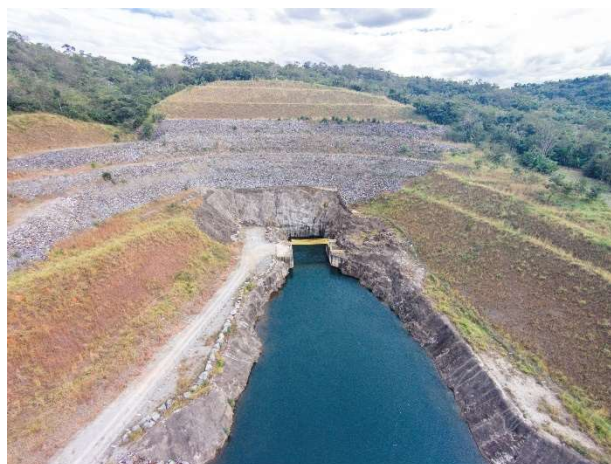
Figura 03 – Vista do canal de adução que conduz água para câmara de carga através do túnel de adução escavado em rocha.
