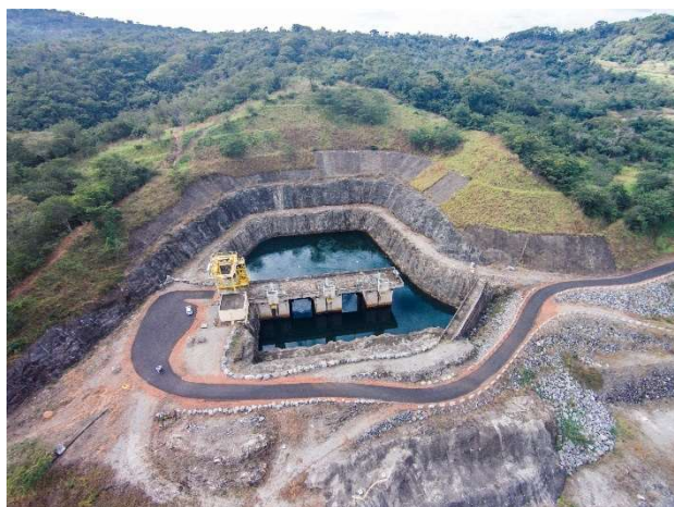
Figura 04 – Vista da câmara de carga (tomada d'água) da UHE Amador Aguiar I
