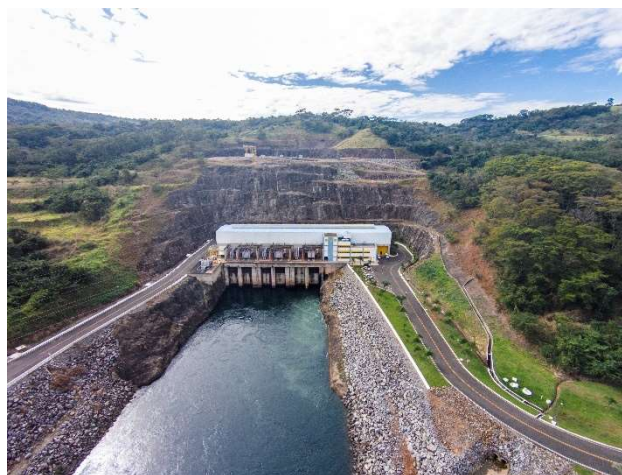
Figura 05 - Vista da casa de força e canal de fuga da UHE Amador Aguiar I
