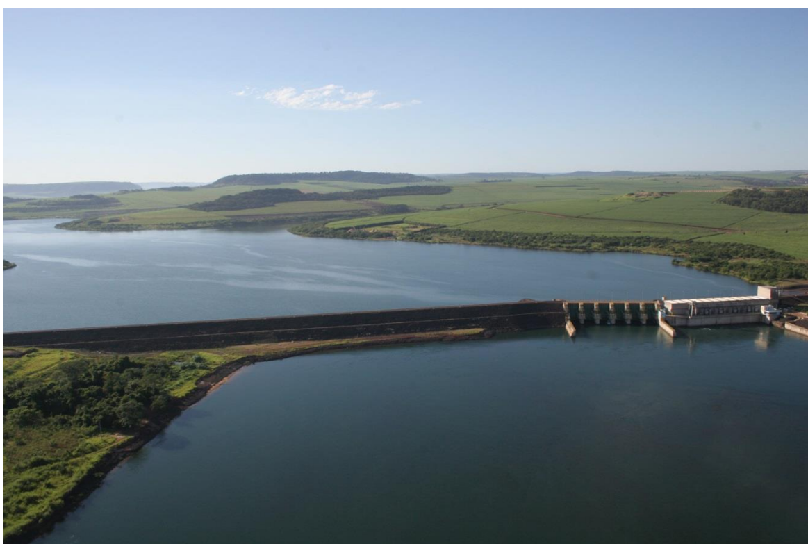
Figura 03 - Vista geral da Barragem da UHE Igarapava
