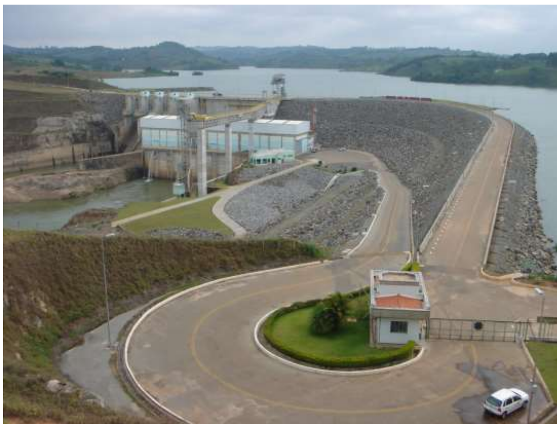
Figura 01 - Vista geral da Barragem da UHE Funil Fonte: Aliança
