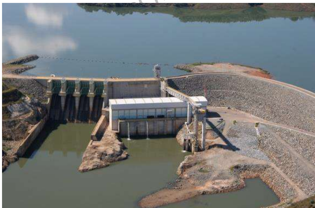
Figura 02- Vertedouro e Casa de Força UHE Funil Fonte: Google
