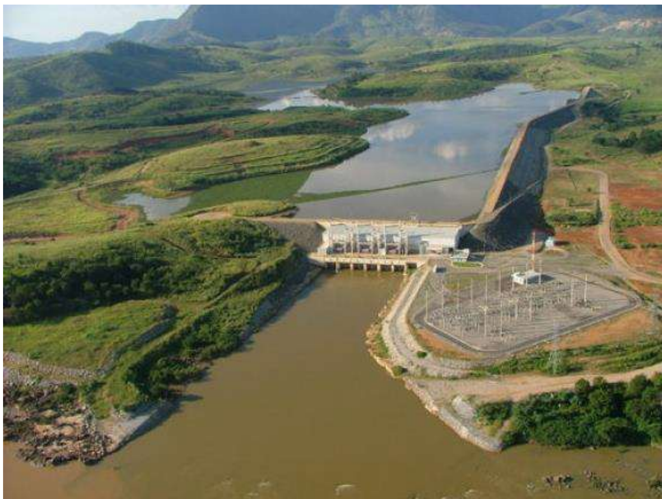
Figura 03: Barramento Auxiliar, Casa de Força e Subestação.
