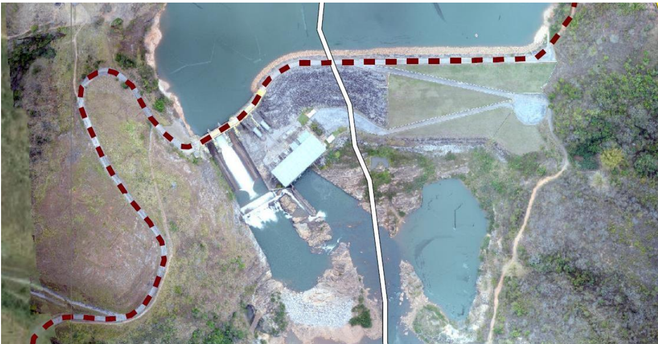
Figura 1 – Vista da UHE Porto Estrela
