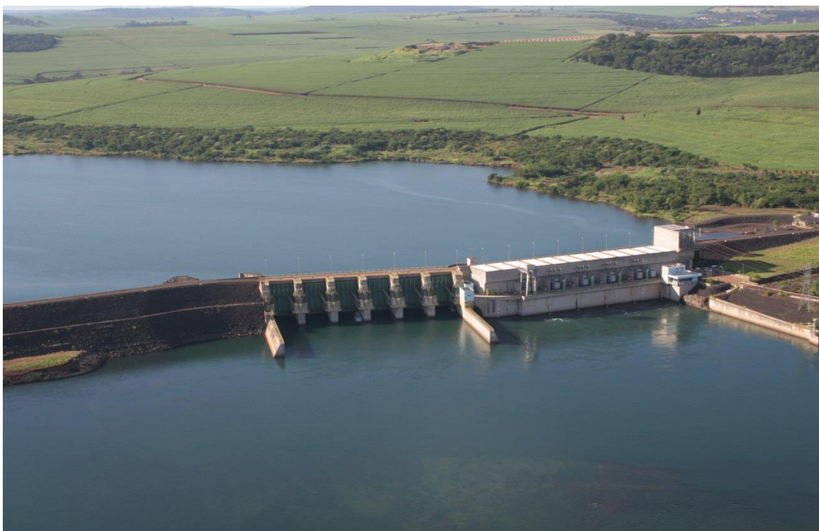
Figura 04 - Vertedouro e Casa de Força UHE Igarapava
