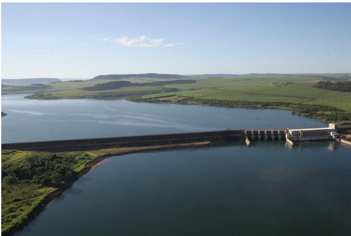
Figura 03 - Vista geral da Barragem da UHE Igarapava
