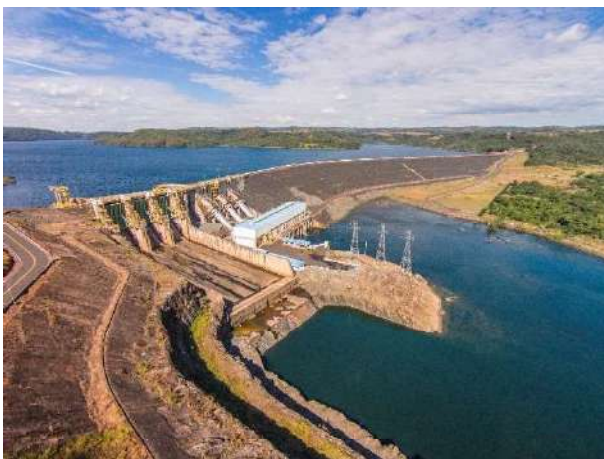
Figuras 02 e 03 - Vistas áreas da barragem, casa de força e vertedouro.
