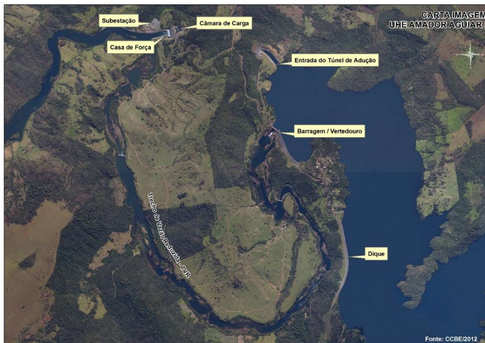
Figura 01– Arranjo Geral da UHE Amador Aguiar I
