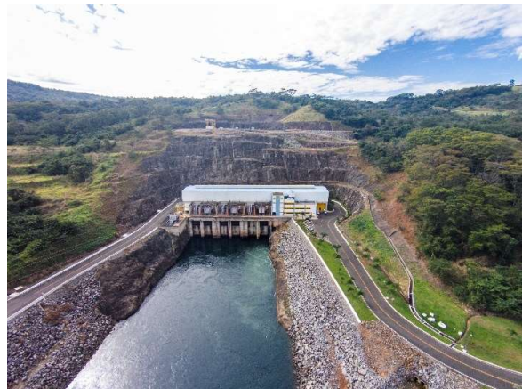
Figura 05 - Vista da casa de força e canal de fuga da UHE Amador Aguiar I
