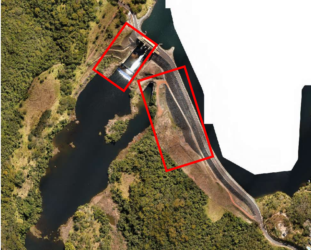
Figura 12 Locais susceptíveis a falha – Barragem principal e vertedouro. Fonte: Ortofotos (CF Engenharia, 2023).
