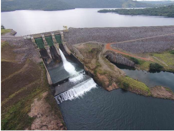
Figura 02 – Vista da barragem e vertedouro com válvula dispersora acoplada na estrutura do vertedouro.
