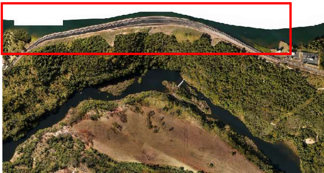
Figura 13. Locais susceptíveis a falha – Dique. Fonte: Ortofotos (CF Engenharia, 2023).
