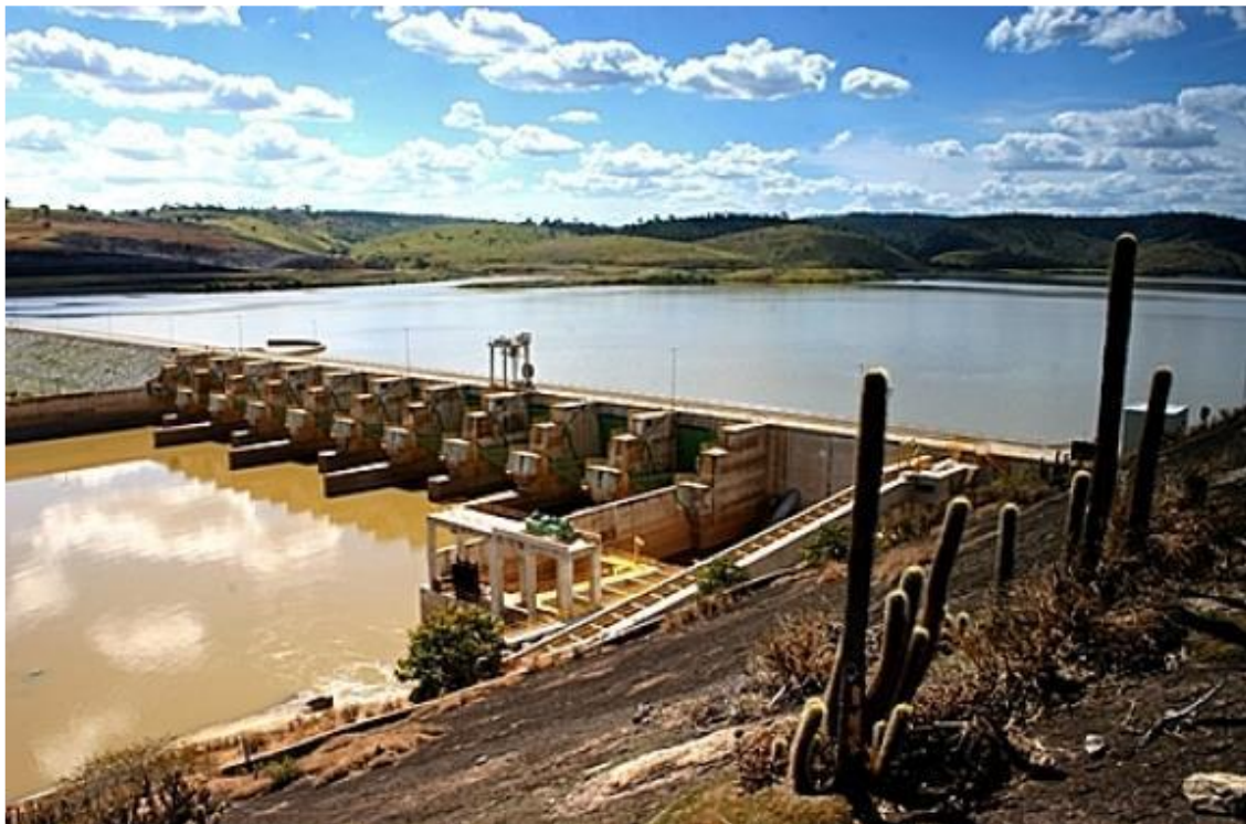
Figura 02: Barramento principal da UHE Aimorés
