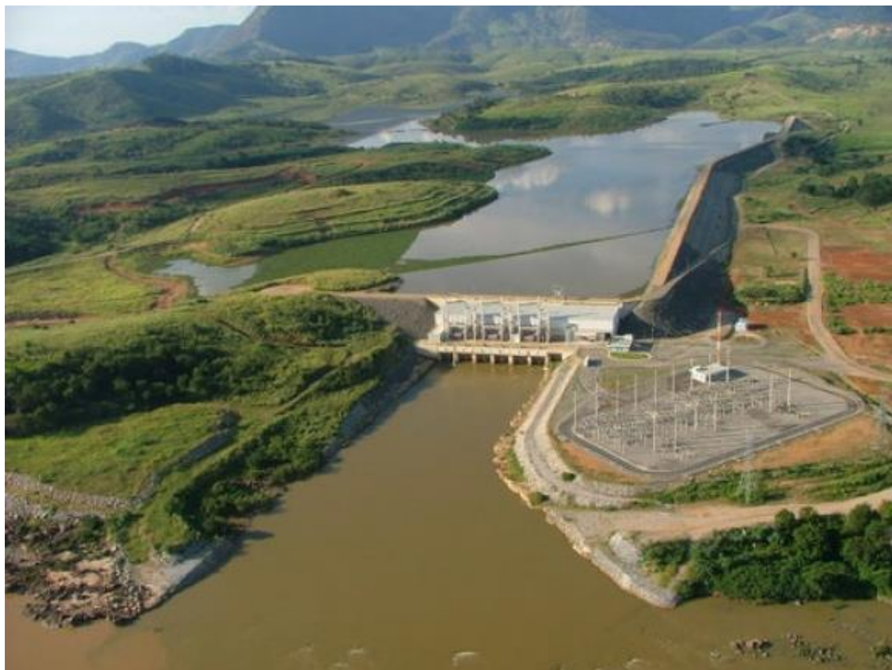
Figura 03: Barramento Auxiliar, Casa de Força e Subestação. Fonte: Aliança
